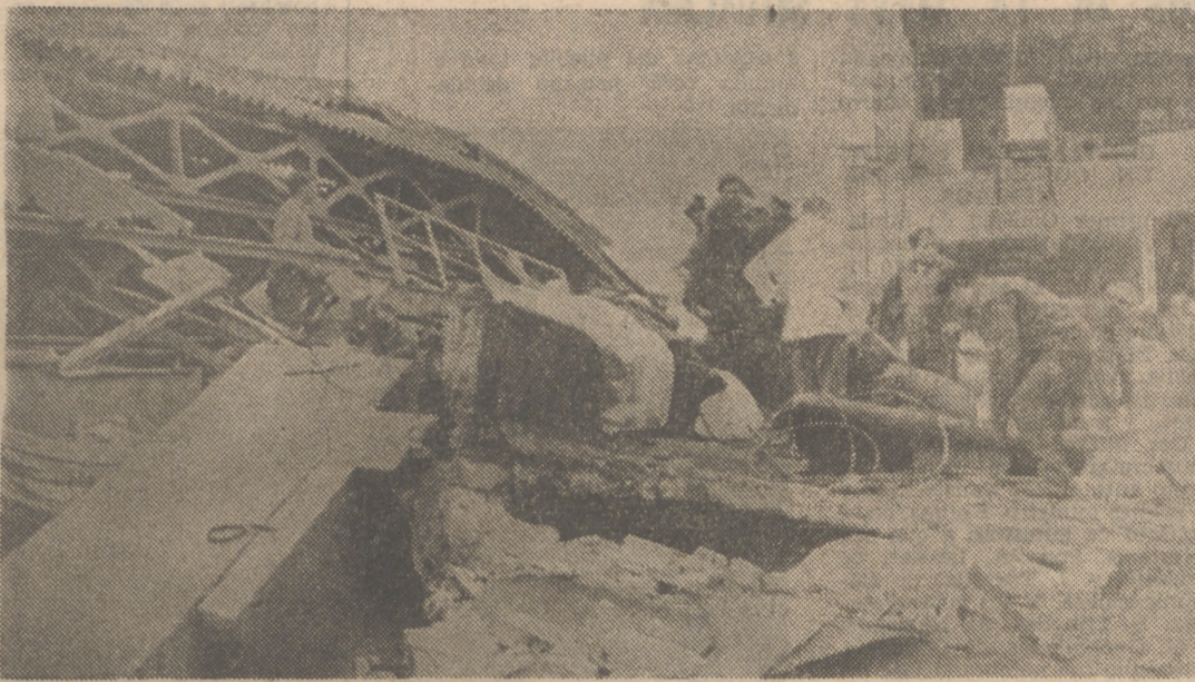
Sobre un montón de escombros, los equipos de rescate realizan las operaciones de recuperación de las víctimas del trágico suceso de la fábrica Frimotor en Luchana-Erandio
