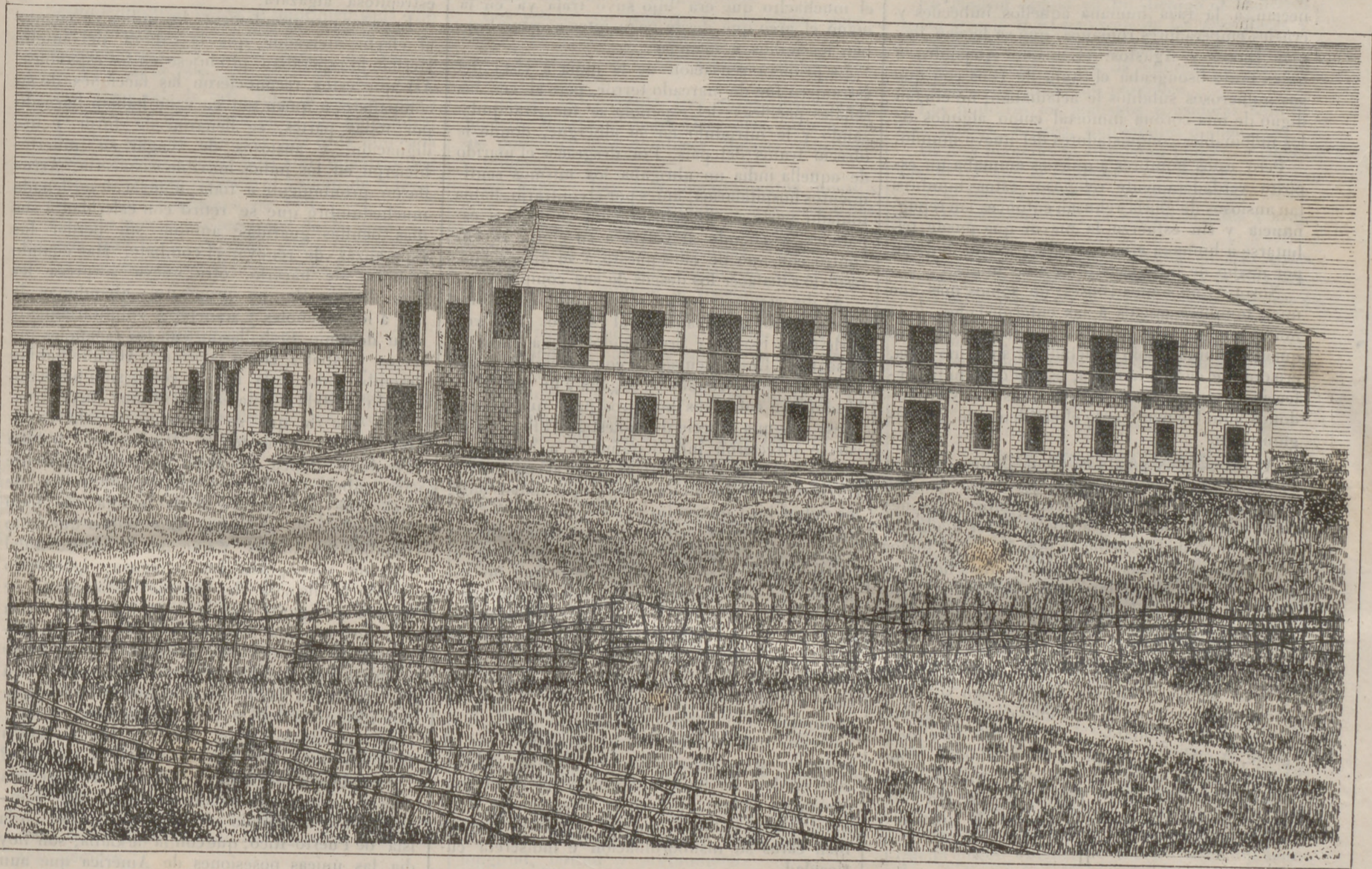
EL HOSPITAL DE LAZARINOS (EN OBRA) DEL OBISPADO DE NUEVA-CÁCERES.
