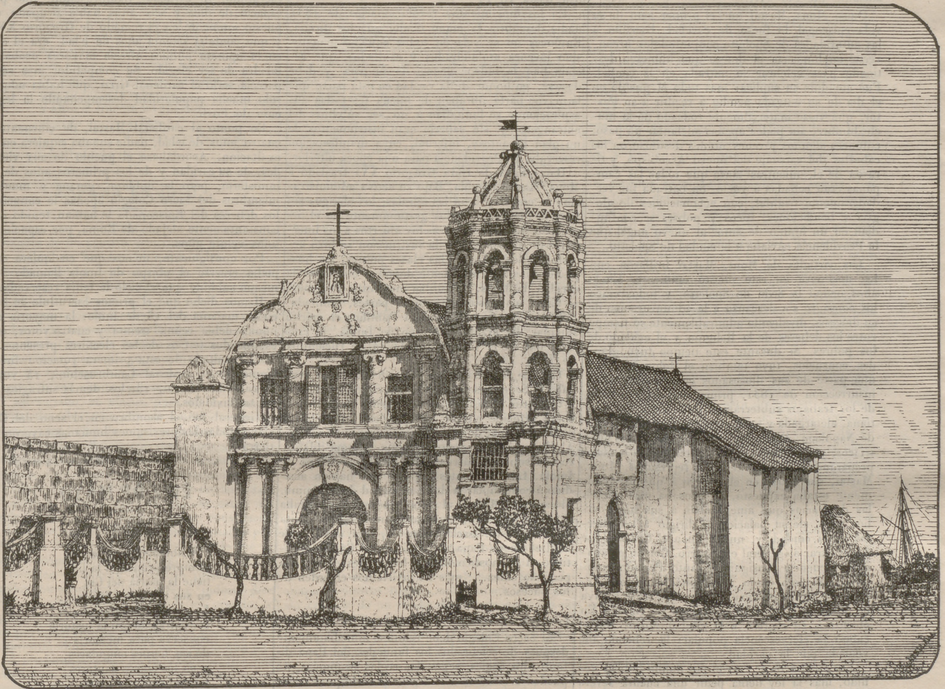
(CAVITE.) IGLESIA Y CONVENTO DE SAN ROQUE.
