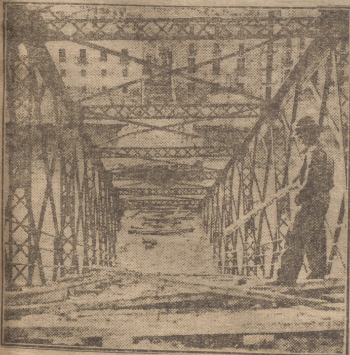
Las hordas marxistas, ante la arrolladora acción de las tropas nacionales, no oponen otra defensa que la cobarde huida o la destrucción sistemática. La "foto" representa un magnífico puente sobre el Ebro, volado por la canalla dinamitera.
