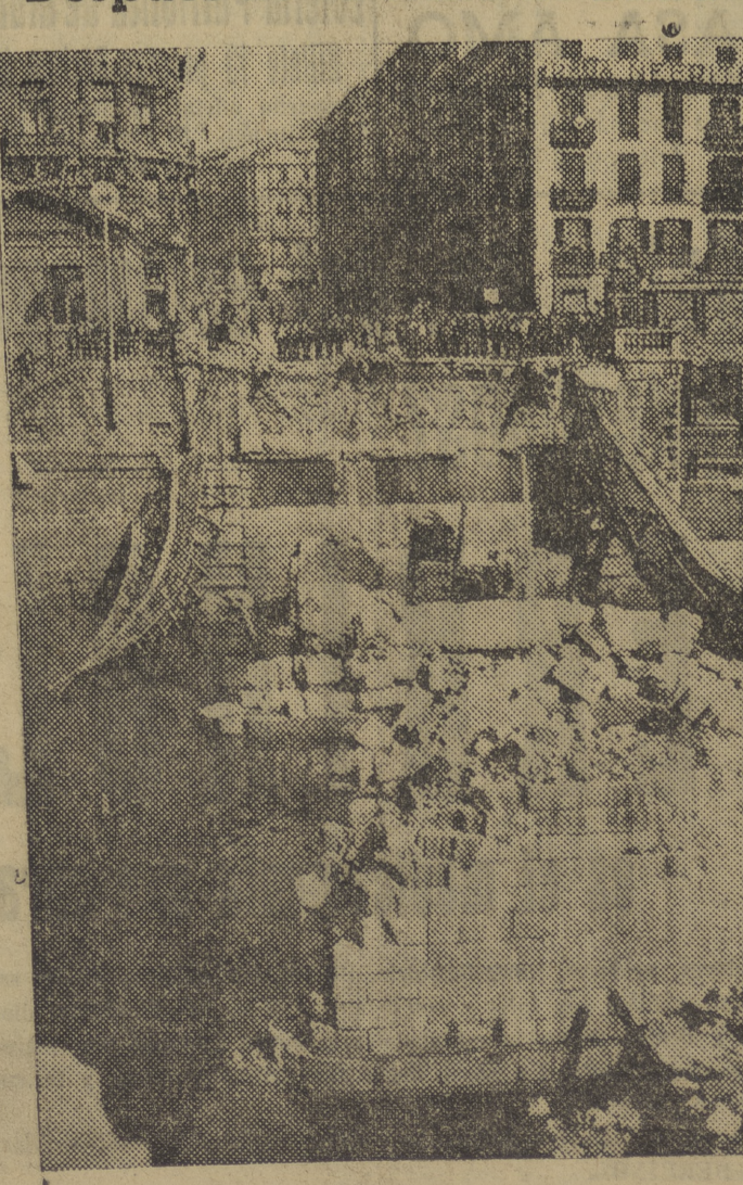
Puente de Isabel II, volado con dinamita por los rojos antes de huir de la ciudad.
