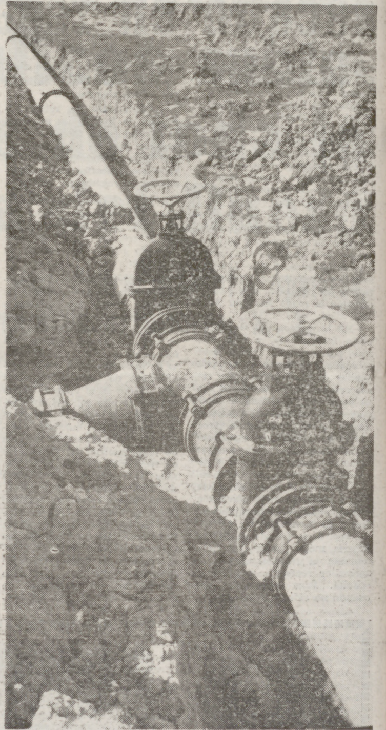
Detalle de la instalación del abastecimiento de agua en La Carolina (Jaén).
