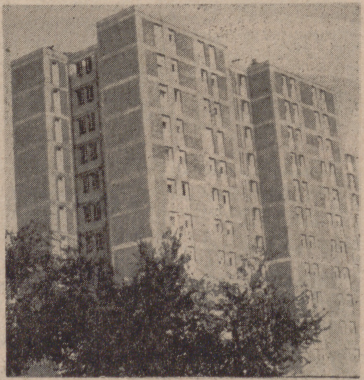
Otro de los nuevos bloques de viviendas para los antiguos chabolistas. Son torres de doce pisos con ocho puertas cada uno. Tienen de tres a cuatro dormitorios, salón, cocina y baño, así como calefacción central, gas ciudad, tenderos, cuartos trasteros y demás servicios de comunidad.
