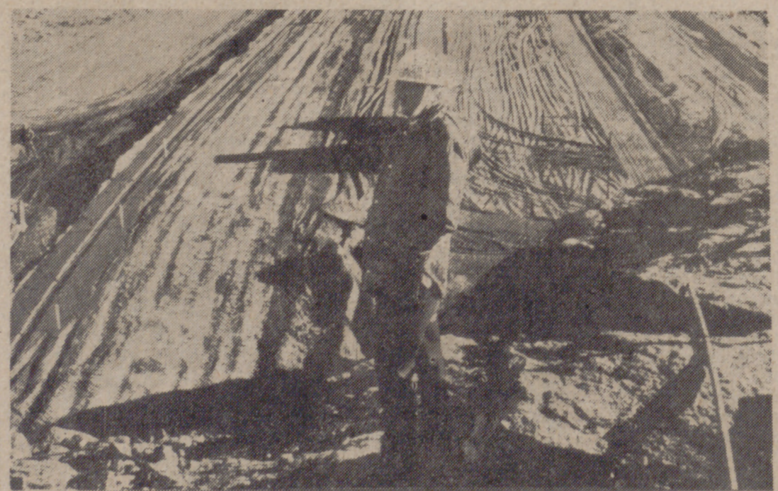
Nuestro compañero, en su visita sobre el muro de contención en el que no se ha empleado ni un solo kilo de cemento. — (Foto PYRESA.)
