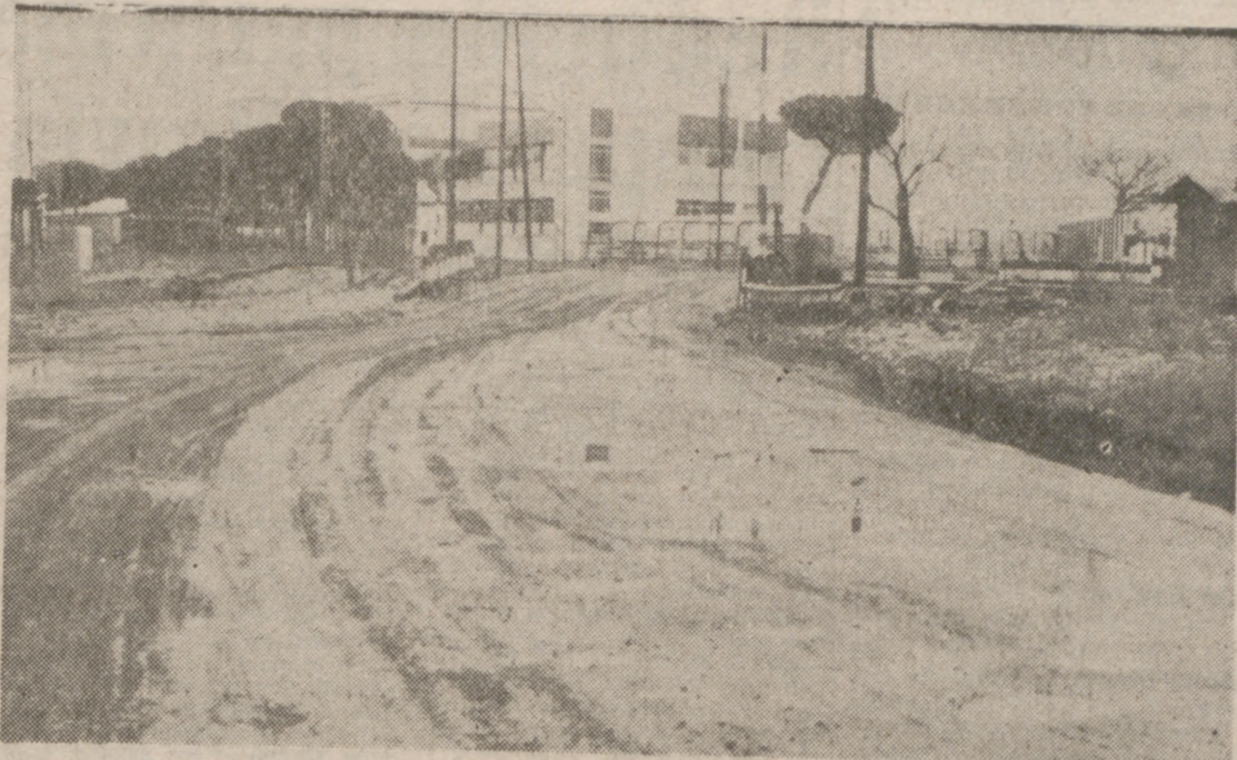
El acceso por las Arcas Reales presenta deficiencias graves.
