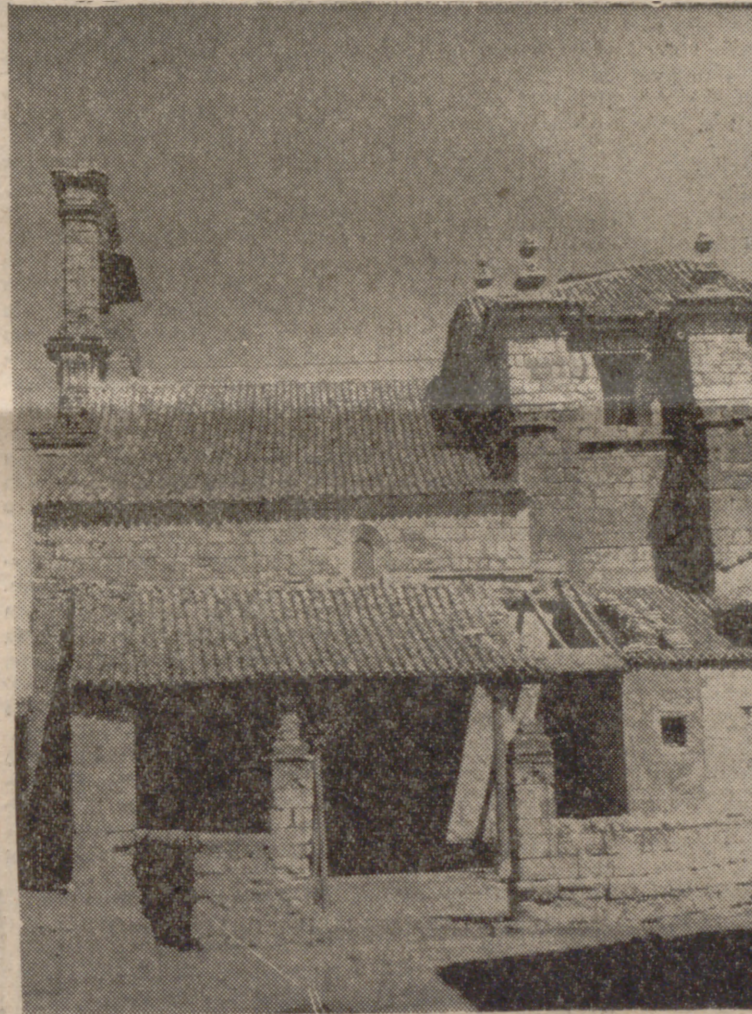
El templo de Santa María de Azogue con el porche hundido, y en el que trabaja el propio párroco para su reparación.
