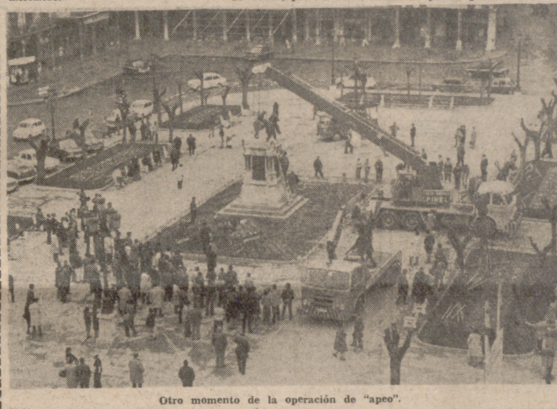
Otro momento de la operación de "apeo".
