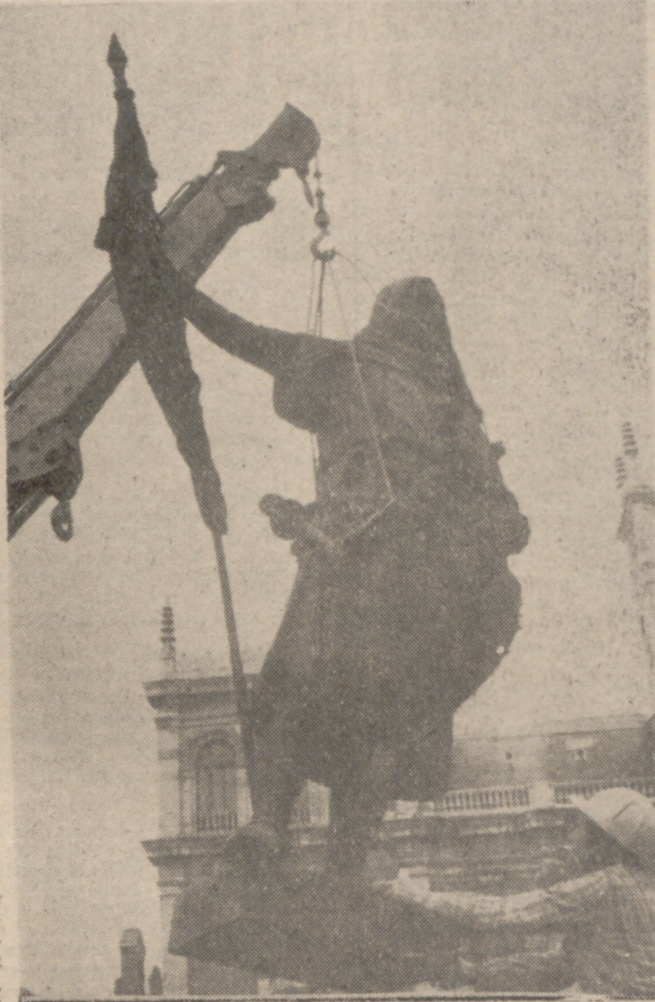
El Conde, por los aires, levantado por la grúa.
