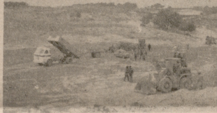
Vista parcial de las obras donde se está construyendo el campo de deportes.
