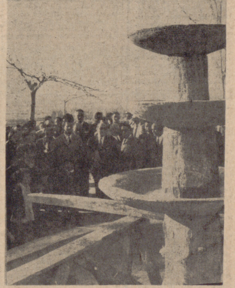
En el Parque Municipal de Mayorga, el Gobernador Civil y Jefe Provincial contempla la obra en construcción de una fuente con estanque.
