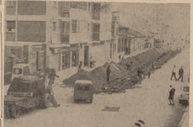
Una vista de las obras que se realizan en la calle de Angel Molina. (Foto Esperanza.)
