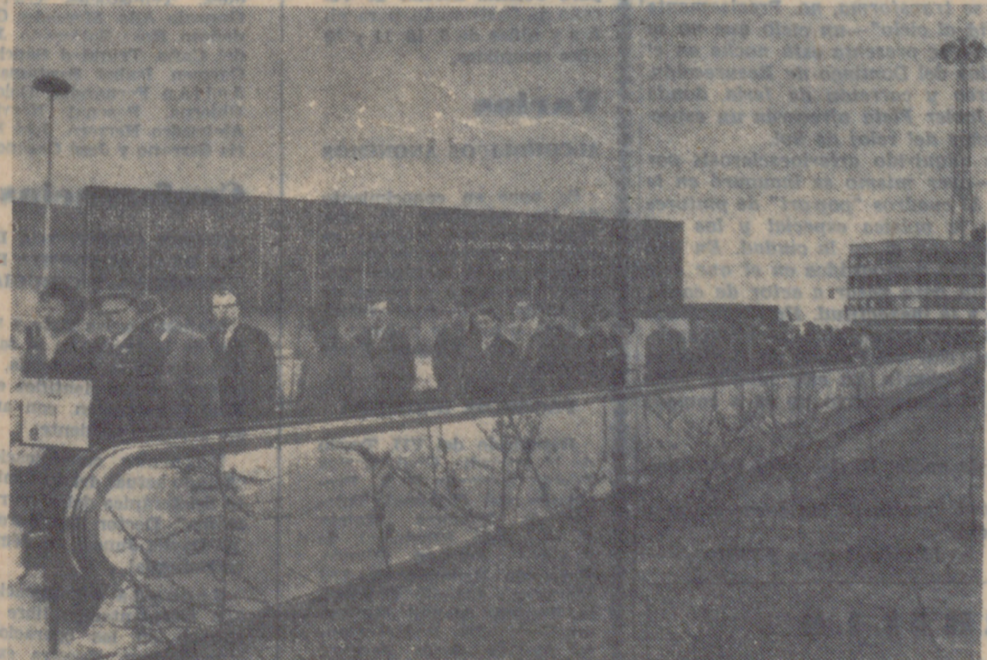
Para que los visitantes de la Feria puedan vencer más rápidamente las grandes distancias entre los pabellones, se han puesto a su disposición no sólo pequeños autobuses, sino también caminos rodantes como éste.
