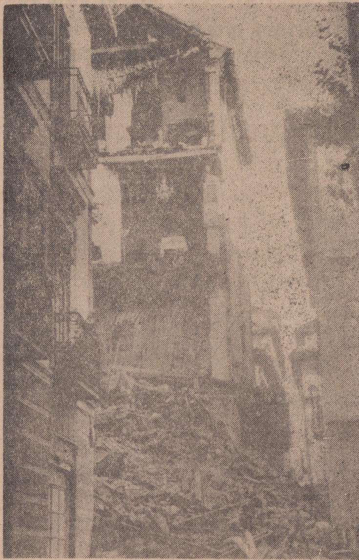
GRANADA. — Como consecuencia de un ligero movimiento sísmico, perceptible en los pisos altos de muchos edificios, se hundió la casa que tenía el número 16 de la calle Varela, declarada en ruina. Afortunadamente no hubo desgracias personales, ya que los vecinos pudieron evacuar el edificio antes de que éste, que tenía grandes grietas, se viniera abajo. (Foto PYRESA.)
