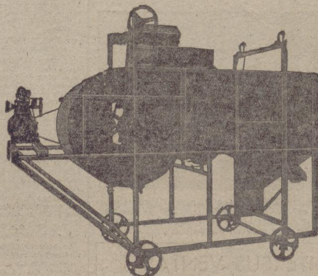
Aventadora Ensacadora Metálica de 1,10 metro y de 1,10 de luz, con zarandones y elevador de madera.
