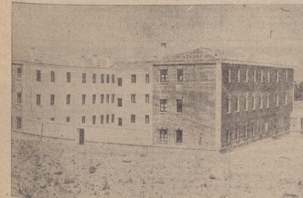
Bajo el nuevo impulso creador de Medina se ha levantado este magnífico edificio, dedicado a Casa-Cuartel de la Guardia Civil.
