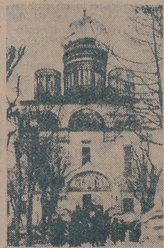
RUSIA.—Demolición del monasterio Simonof, en Moscú.
