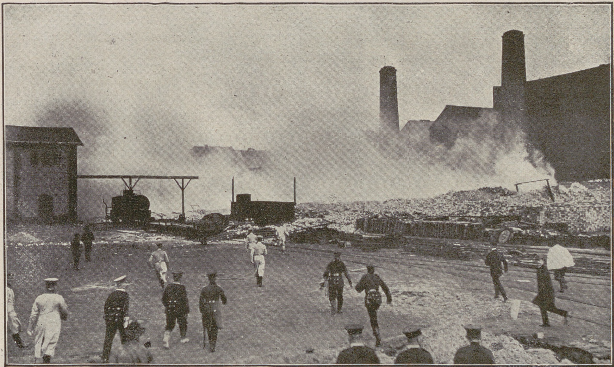
Terrible explosión en la fábrica de gas de la Müllerstrasse de Berlín.—Buena parte del edificio quedó destruido por la fuerza de la explosión, cuyo estruendo formidable dejóse oír en una buena parte de la capital. Nuestra fotografía representa la llegada de las tropas de ingenieros al lugar de la catástrofe.
