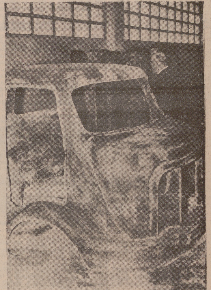
El modelo de cabina de camioneta construido en plástico, que se halla en la nave destinada a la fabricación de este producto, sección nueva en Europa.
