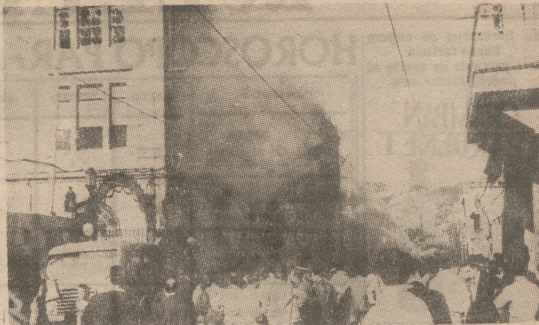
Un incendio reciente en uno de los edificios de las factorías de Hijos de J. Barrera destruyó las oficinas generales y técnicas con toda la documentación y los planos y proyectos. Las pérdidas ya anticipamos que se acercan a los 200 millones de pesetas. (Foto Cifra.)
