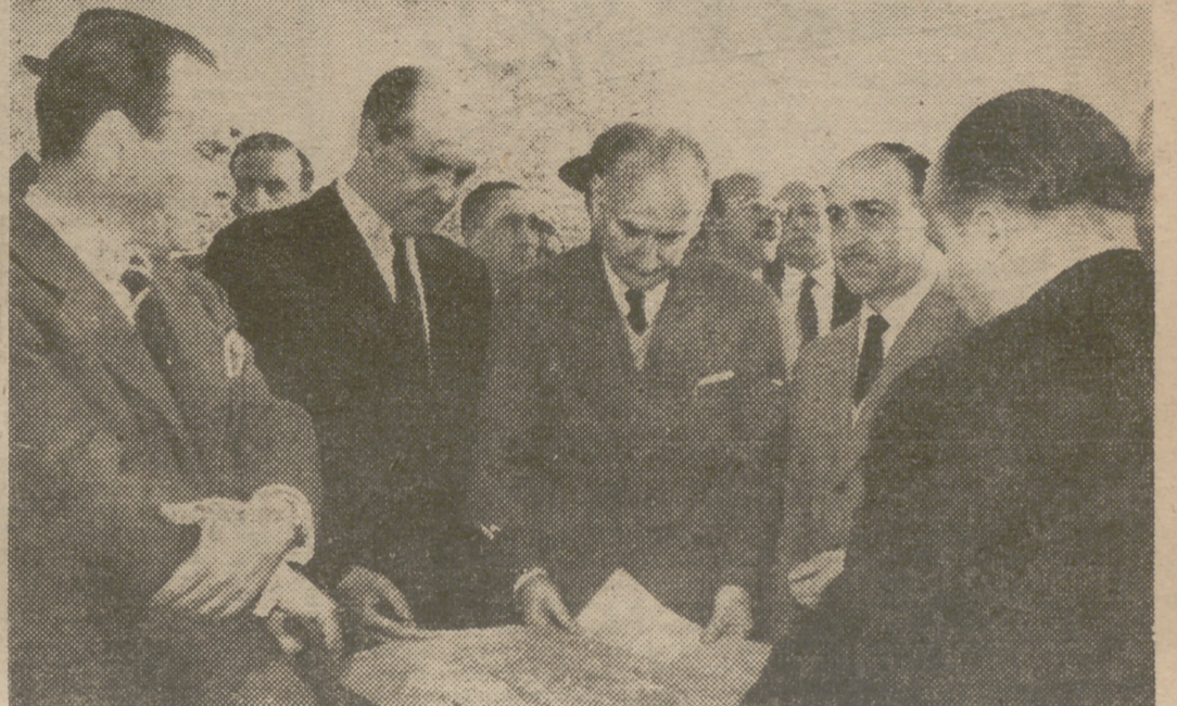
Los ministros secretario general del Movimiento, don José Solís, y el de Vivienda, don José Luis de Arrese, visitaron en la tarde de ayer las viviendas de tipo social que se construyen en Puerta Bonita. Las construcciones visitadas ayer por los dos ministros se encuentran en fase muy avanzada, y dentro de pocos meses constituirán uno de los barrios más modernos, alegres y bien comunicados de la capital de España. Al paso de los señores Solís y Arrese, el vecindario les hizo objeto de su simpatía. (Foto Mamegam.)
