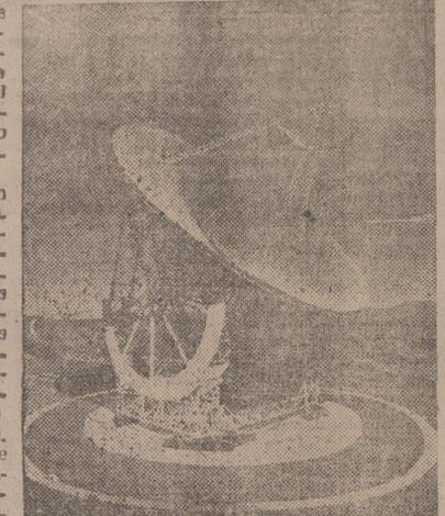
El gran radio-telescopio de Sugar Grove, de la Marina norteamericana, que tiene un receptor parabólico de 200 metros de diámetro (Foto "Europa-Press")
