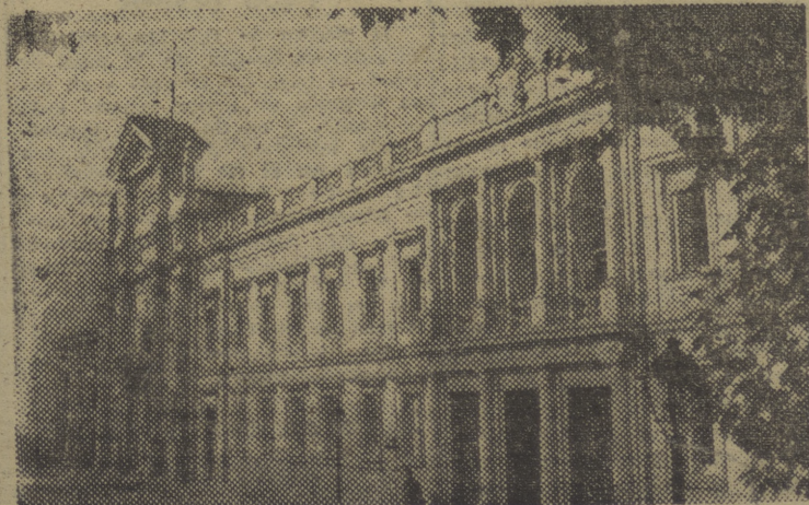
El palacio del Consejo Nacional de F. E. T. y de las JONS, en el antiguo Senado, ha sido remozado en su exterior e interior. Vista de la nueva fachada totalmente terminada
