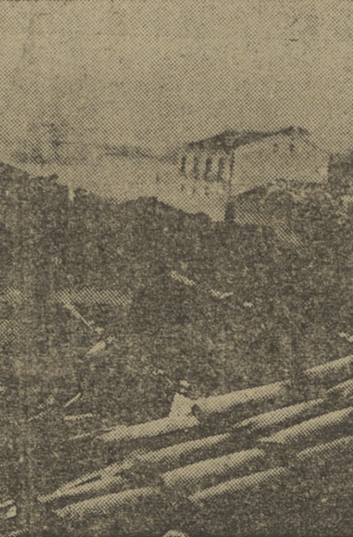
Estado en que quedó la techumbre de la fábrica de pieles que se incendió ayer, de madrugada, en el Capiscol. — Información del siniestro en segunda página de nuestra edición para Burgos. (Foto Villafraanca.)
