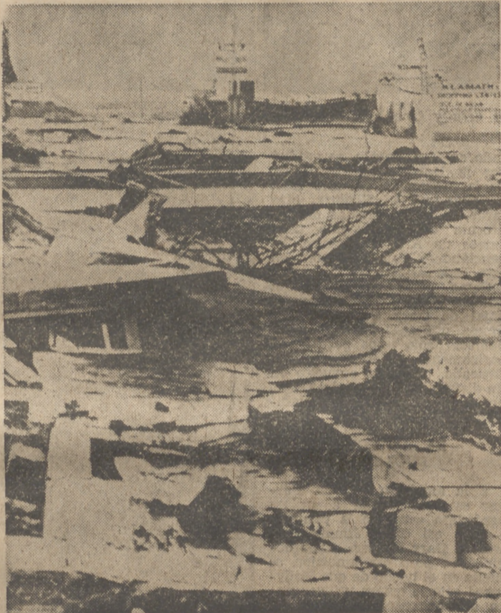
Esta es una vista penosa de un suburbio de la ciudad californiana de Clamakh, totalmente destruida por las inundaciones, que la asolaron. En primer término de la foto se ve la cuarteada carretera nacional 101, que ha quedado totalmente intransitable.
