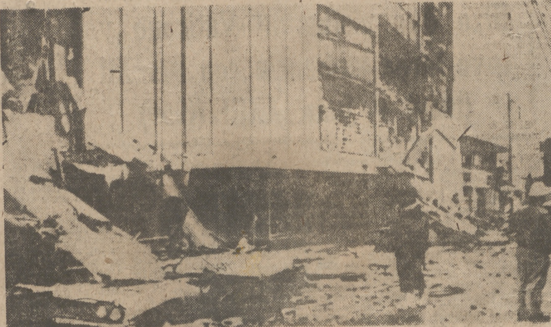
Anchorage ha sido la población de Alaska que más ha sufrido los efectos del catastrófico terremoto. La calle principal quedó casi totalmente destruida, derrumbándose muchos edificios. En la foto se aprecia cómo un muro ha caído sobre un automóvil
