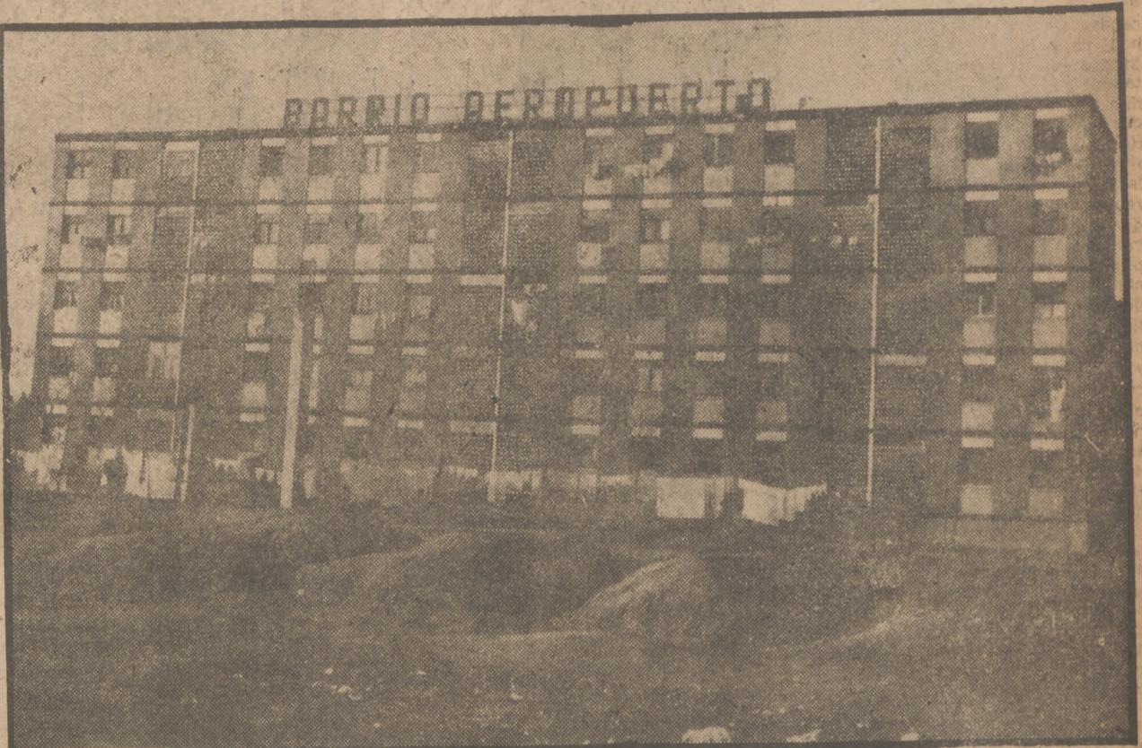
Este es el barrio del aeropuerto que motiva el reportaje. A simple vista pueden apreciarse las dificultades que para el acceso a las viviendas representa la falta de urbanización de la zona edificada
