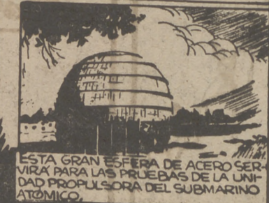
ESTA GRAN ESFERA DE ACERO SERVA PARA LAS PRUEBAS DE LA UNIDAD PROPULSORA DEL SUBMARINO ATÓMICO.
