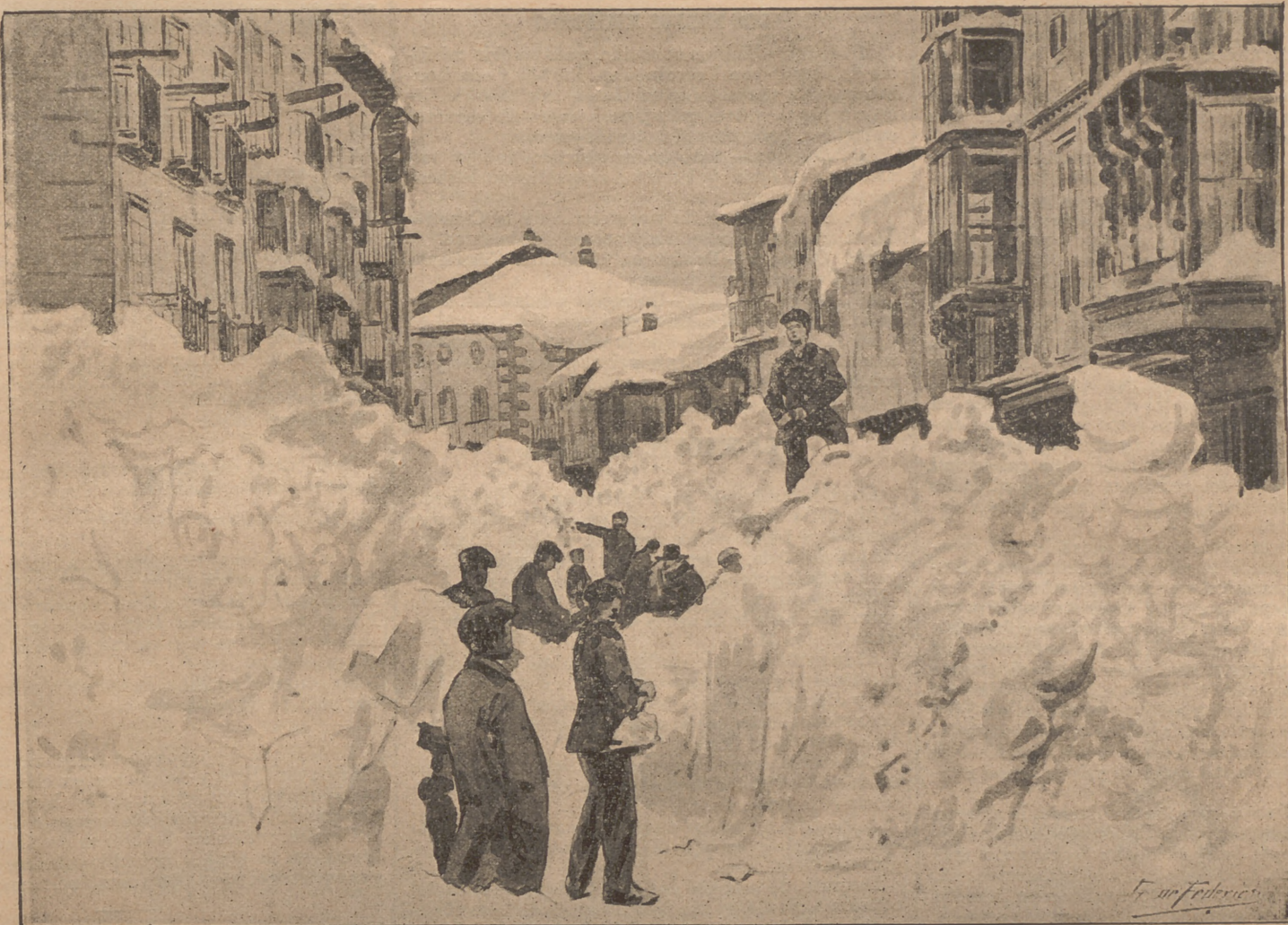
LOS PEONES DEL AYUNTAMIENTO ABRIENDO PASO POR LA CALLE DEL PUENTE
