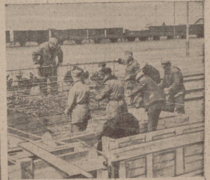
También el Este es fortificado. Hombres rusos trabajan en estas obras.—(Orbis-Foto.)
