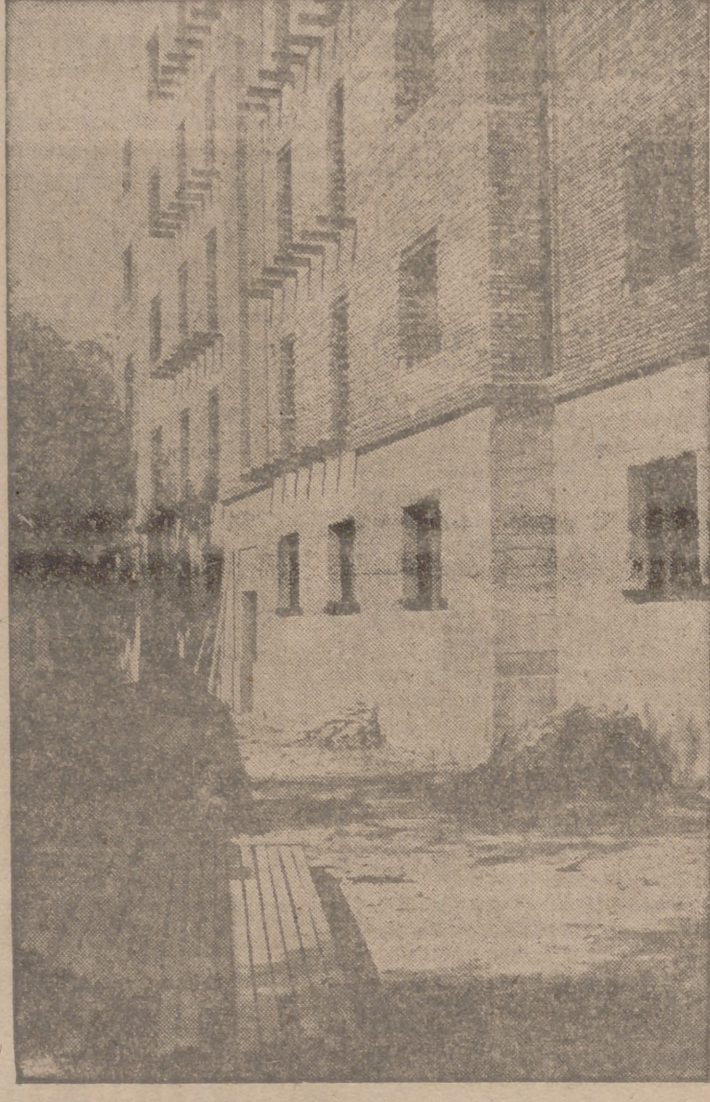
VIVIENDAS PROTEGIDAS.—GRUPO "GENERALISIMO"
