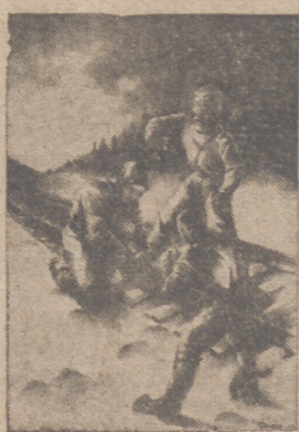
En el Norte de Rusia, sobre la superficie nevada, soldados alemanes reparan las averías de la línea férrea que asegura el abastecimiento
