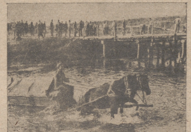
Los zapadores alemanes, con una rapidez enorme, construyen nuevos puentes para sustituir los destruidos. Mientras tanto, los carros de refuerzo toman su camino a través de las aguas
