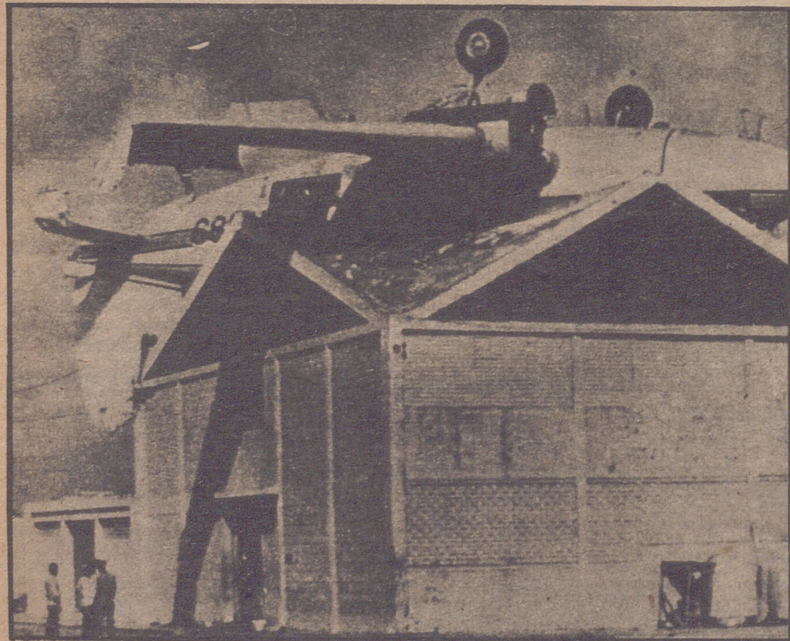
Como consecuencia de la fuerza del huracán "David", este avión fue a parar sobre el tejado de esta casa, en Santo Domingo. El aparato estaba aparcado no a mucha distancia del lugar.
