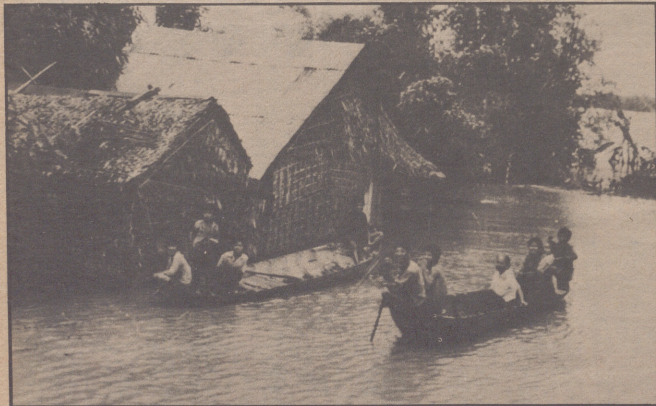
BINH THANH (Vietnam del Sur). — El pasado mes de septiembre el tifón "Lola" azotó Indochina, provocando grandes inundaciones. En la foto, los habitantes del poblado de Binh Thanh, situado en el delta del Mekong, circulan en una barca por lo que antes era una calle. En la provincia de Dong Thap se inundaron en total unas 87.000 hectáreas de tierra. (Telefoto Efe-Upi)
