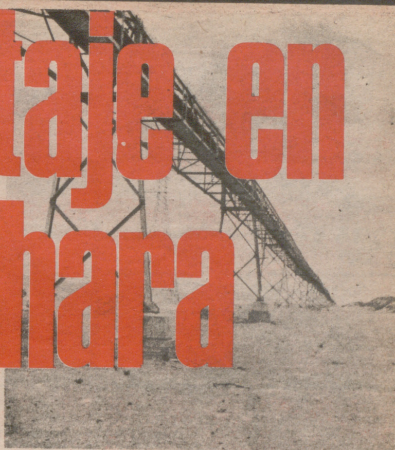
Montaje de un puente de la cinta transportadora sobre las dunas
