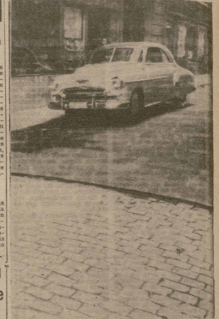
La calle del Barquillo está siendo alfombrada de alquitrán. Esta es una sana medida adoptada por el Ayuntamiento, habida cuenta del intenso tráfico que padece a diario dicha calle y en la que hace tiempo eran visibles algunos graves desperfectos en su adoquinado. (Foto Torrecocha.)
