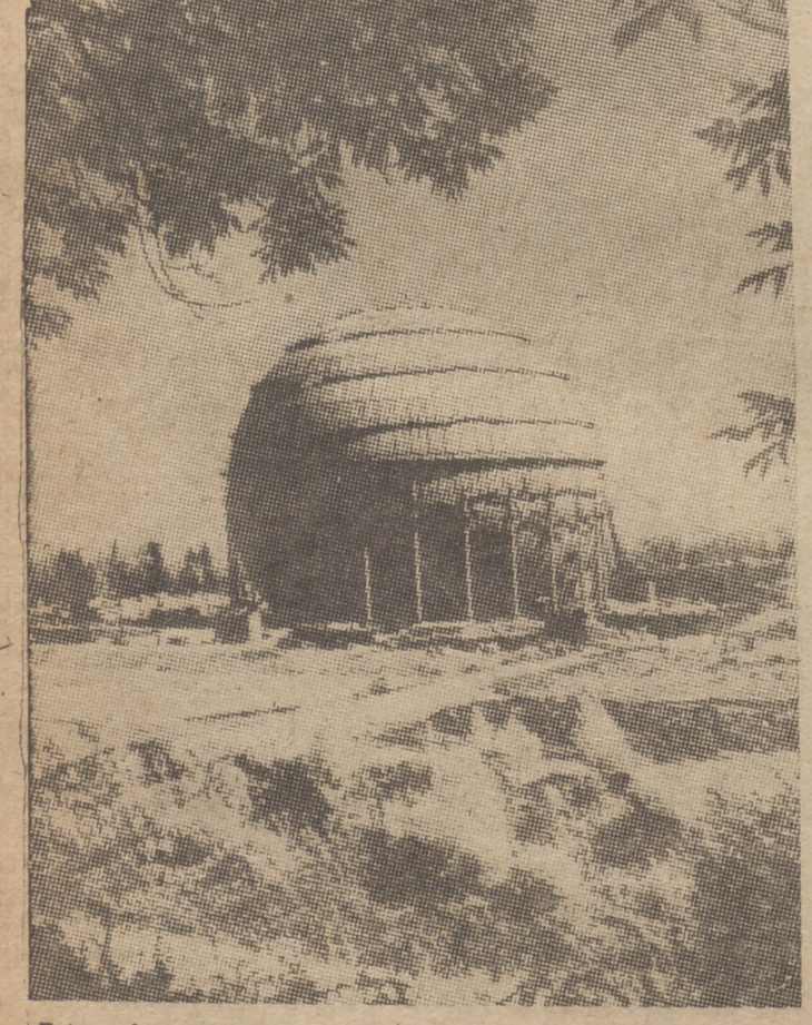
Esta esfera pertenece a un acelerador de partículas mediante cargas eléctricas estáticas, destinado a una fábrica de submarinos atómicos. Se han empleado unas cuatro mil toneladas de acero en su construcción. Su altura es la de un edificio de ocho pisos. (Foto Cifra.)
