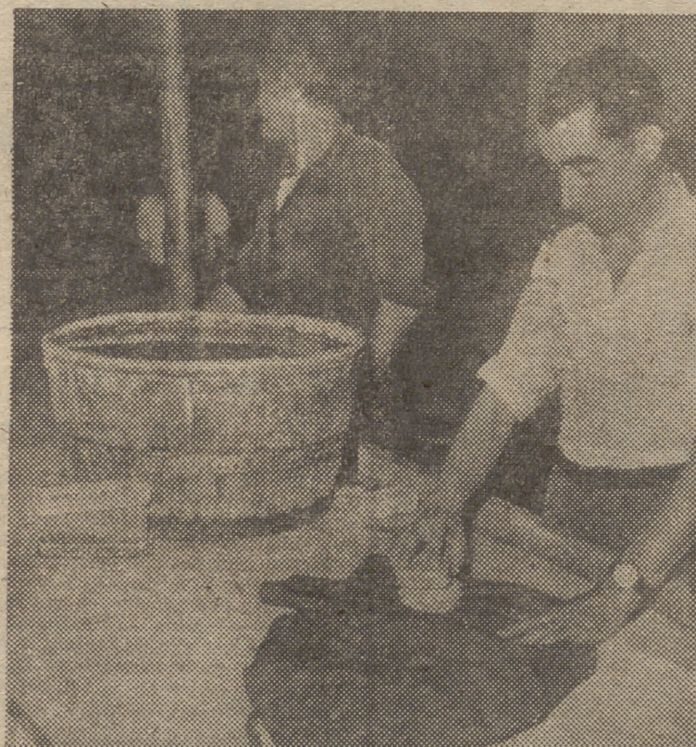
Si la ropa no ha quedado bien después de la "limpieza en seco", pasa a esta sección de "mojado y lavado". Aquí vemos a uno de los empleados ayudando a quitar la suciedad de la Prenda, frotándola con un cepillo de raíz. Las fibras del tejido quedan resentidas después de todas estas faenas de limpieza.
