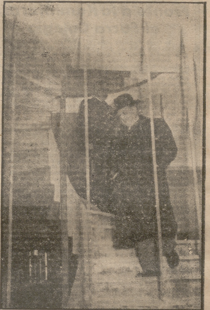
El alcalde de Roma, señor Rebecchini, durante su visita a las obras del ferrocarril suburbano, recorrió el túnel que, partiendo del lago de la Casa de Campo, llega hasta la plaza de España. (Foto Cifra.)
