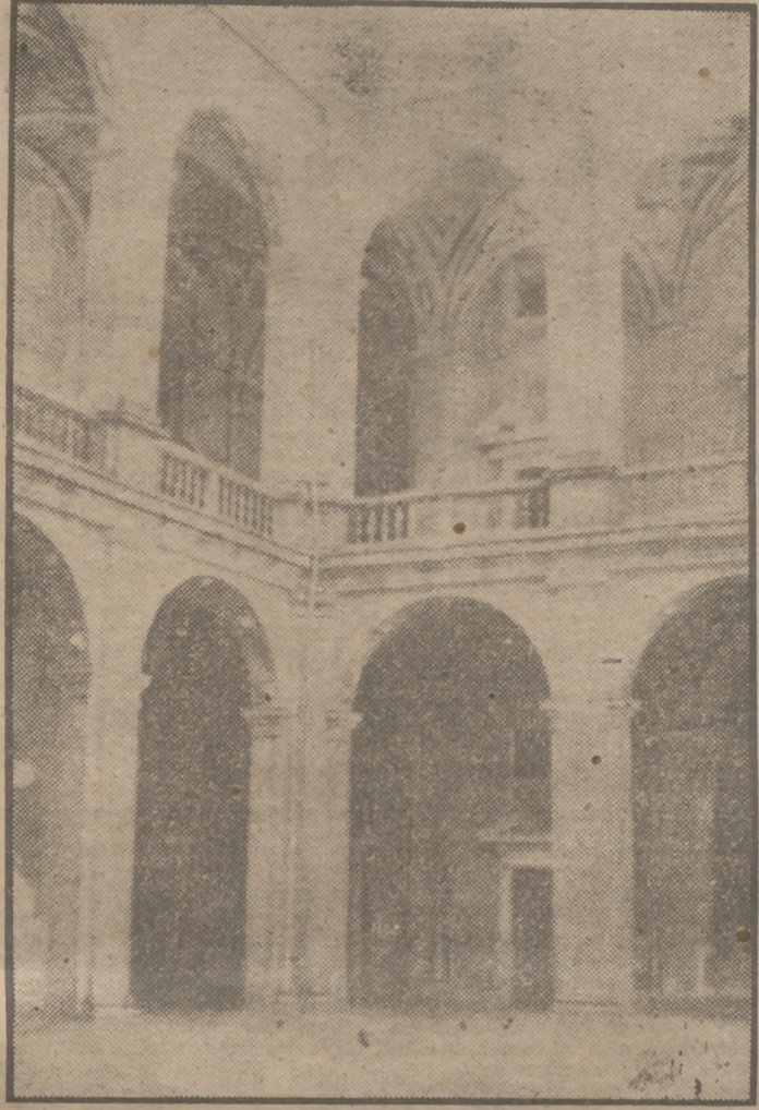
Vista parcial del patio del palacio de don Alvaro de Bazán, que ha sido cedido al Ministerio de Marina.
