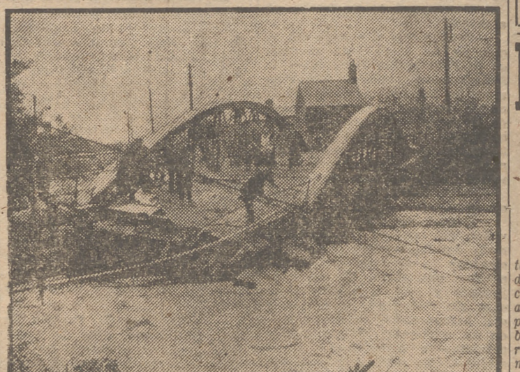
Una gran tempestad asoló días pasados las regiones del norte de Inglaterra. Las fotos registran dos aspectos de los destrozos causados por el temporal en dos aldeas, Northumberland y Berwickshire, donde arrastró la fuerza de las aguas a un puente y arrancó y destruyó árboles y vehículos a su paso. (Foto A. P.)
