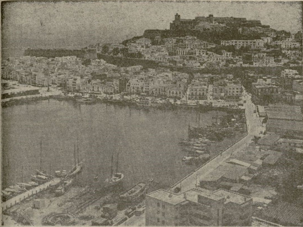
VISTA GENERAL DEL PUERTO DE IBIZA. QUE VA A SER MEJORADO. CUANDO TERMINA LA CARRETERA QUE VEN A LA DERECHA, SE INICIA EL NUEVO PASEO MARITIMO.
