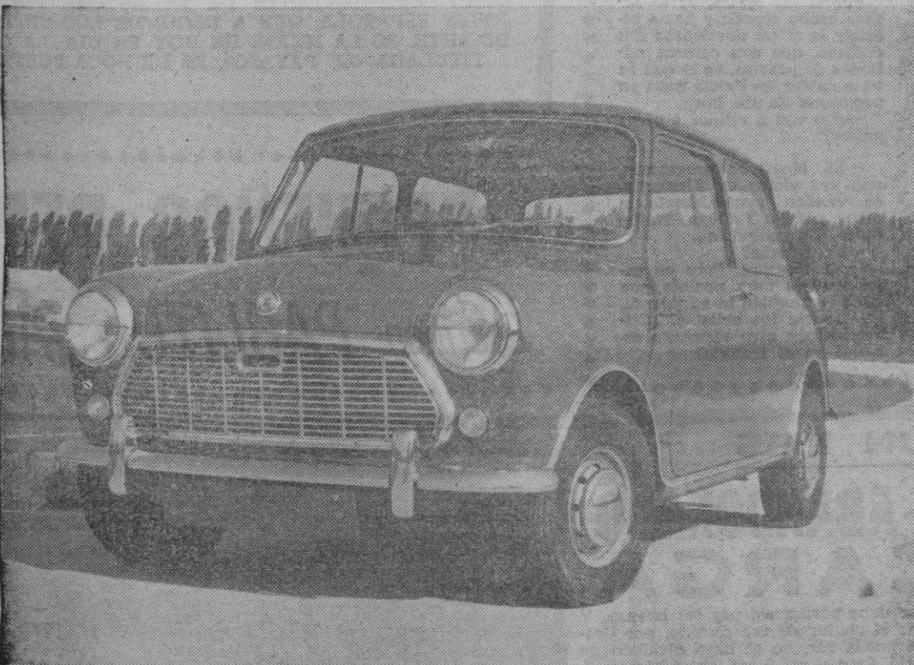
Cuando en el año 1957 se pensó por primera vez en el Mini, ningún automóvil inglés construido en serie hasta la fecha, disponía de tracción delantera y suspensión independiente, ni combinaba un circuito cerrado de refrigeración por agua, con motor de cuatro cilindros montado transversalmente entre las ruedas delanteras.
