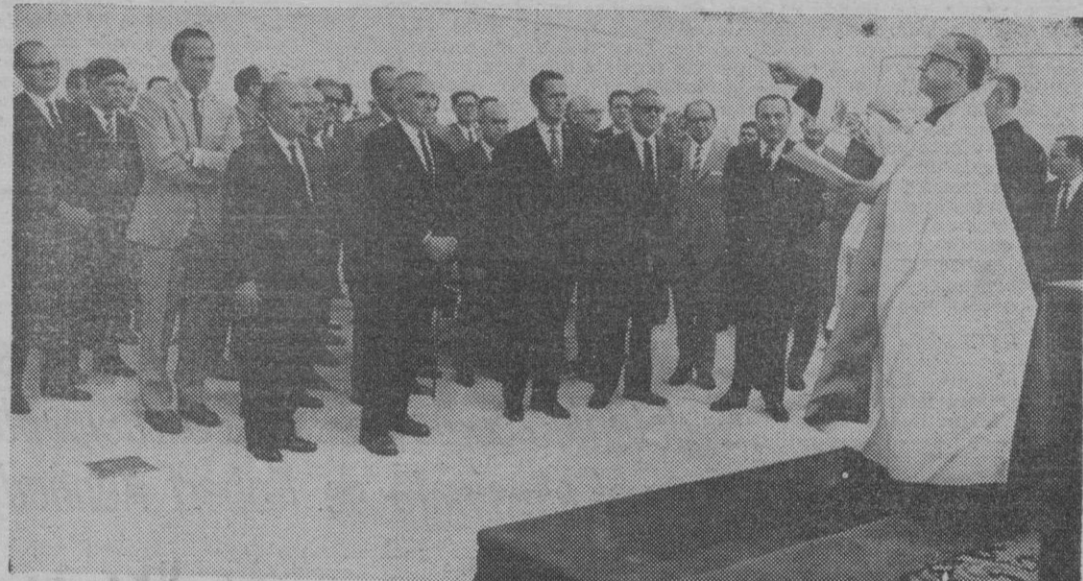
SOLEMNE MOMENTO EN QUE EL VICARIO GENERAL DE LA DIOCESIS, RDO. SEÑOR FIOI, PROCEDE A LA BENEDICION DE LA NUEVA CENTRAL ELECTRICA «SAN JUAN DE DIOS».
