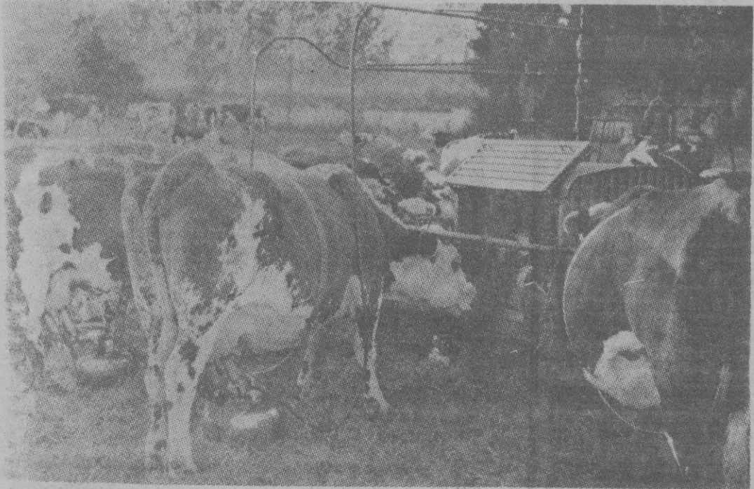
El ordeño mecánico también se puede efectuar en el prado, sin necesidad de trasladar el ganado a la vaquería. Por medio de un remolque se transporta el motor y todos los aparatos y accesorios de la máquina de ordeño. El ganado, de esta forma, no se fatiga y se gana mucho tiempo.
