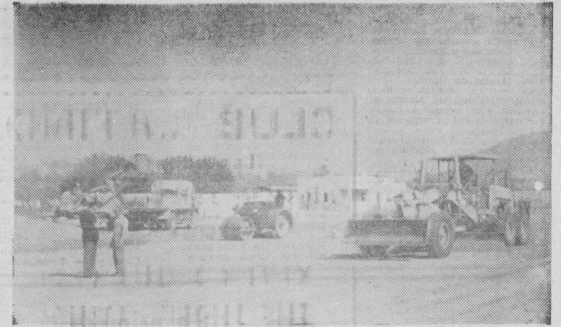
Nuestro corresponsal GARA hablando con el encargado de las obras de construcción del piso del campo de fútbol. Maquinaria que se utiliza para ello. (Foto Fermin — Lluchmayor)
