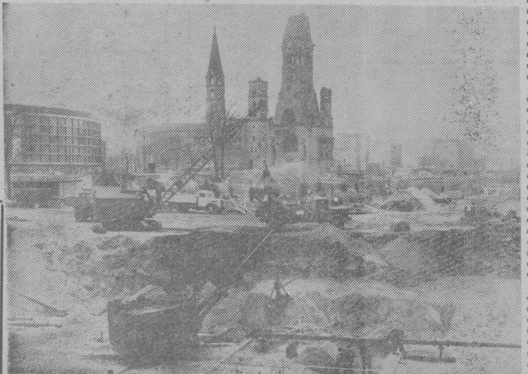
UN ASPECTO DE LA RECONSTRUCCION DE BERLIN. — (Foto Cifra)
