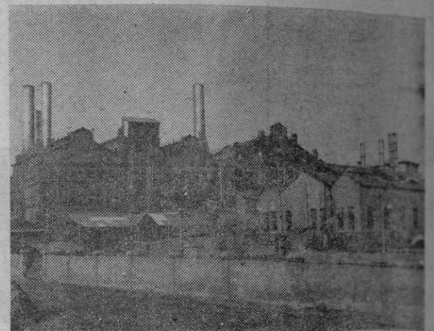
Estas dos fotos podrían titularse el «Ayer y el Hoy» de «Gas y Electricidad S. A.». Arriba, una vista aérea de la Central de Puerto Alcudia, mientras que en la parte inferior aparece la silueta de la antigua fábrica del Molinar.
