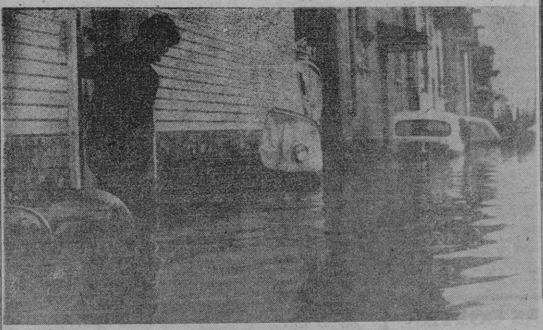
TURIN. — Un gran temporal de lluvia ha azotado desde el domingo pasado día 4 a todo el Piemonte, produciendo inundaciones y graves destrozos. En la foto, una calle de Nichelino, cerca de esta ciudad completamente inundada. — (Foto Cifra.)
